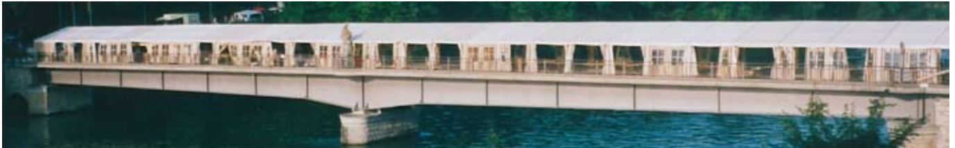
...auf Brücken (Rheinbrücke, Zeltlänge 96m)
